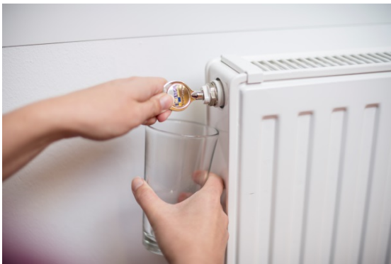
Abbildung 4: Entlüften des Heizkörpers © Robert Herbst www.pov.at
